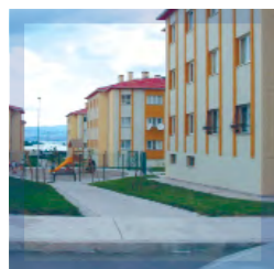
Izmit Yenikoy Earthquake Houses (Terra 1) Реконструкция домов, пострадавших от землетрясения в районе Йеникой (TERRA -1)
