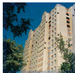
Multistorey Residential Building Многоэтажный жилой комплекс
