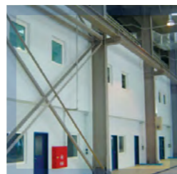
Schlumberger Production Facility Производственная база Шлumberгер
